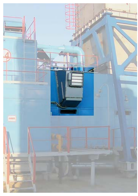
Рис. 3. Внешний вид модуля вентиляции и обогрева, установленного на укрытии двигательного отсека ГПА-Ц-16
